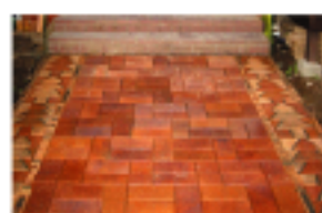
アブローチ インターロッキングもグイラーにより切断加工して施工しました。
